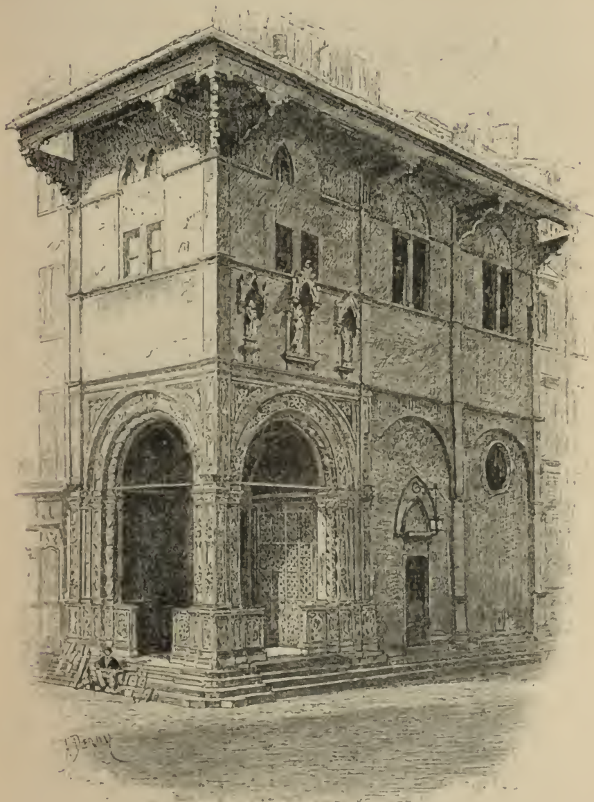
LOGGIA DEL BIGALLO.
